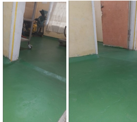
Gambar 2. Ruang produksi dan ruang pengemasan setelah pengecatan
